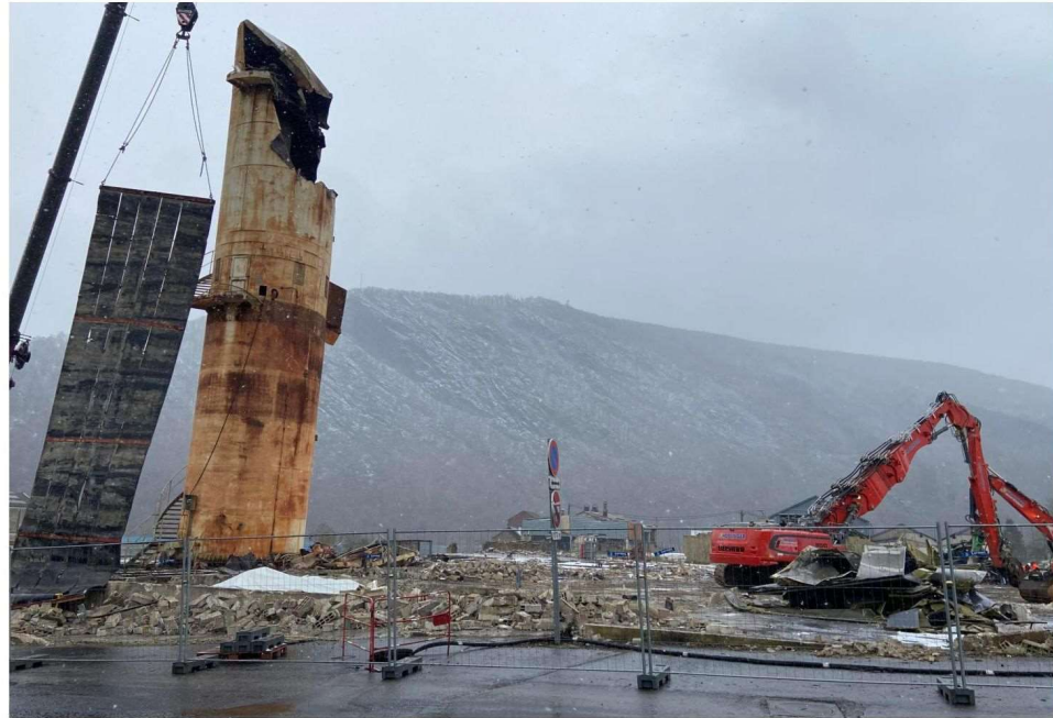
La démolition du silo encore plein de 10 tonnes de sable a commencé hier matin. J.L.
